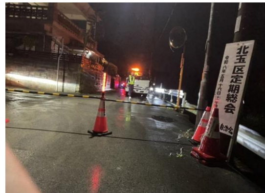
●北谷町吉原道路決壊 ※写真は、沖縄県中部土木事務所提供
